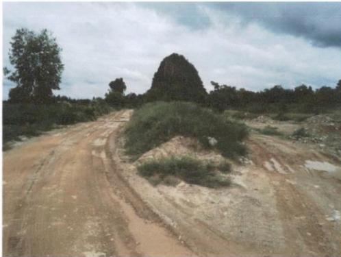
รูปที่ 8 แสดงคันกั้นดิน โดยที่ใช้เศษหินและดินปรับแต่งเป็นแนวกันน้ำบ่อบริเวณด้านตะวันออกทางเข้าโครงการฯ
